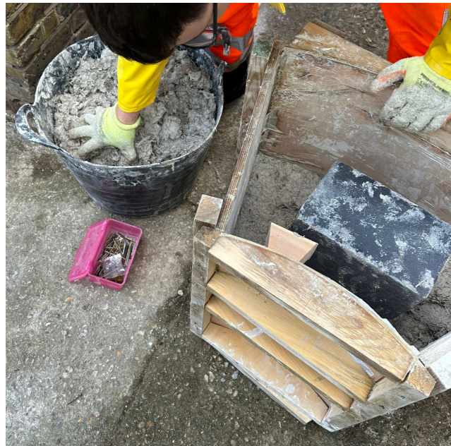
Fig.88 - POURING THE MIX
